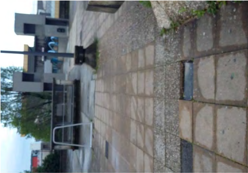
Constat de la disparité des revêtementst extérieurs non entretenus et manquants
