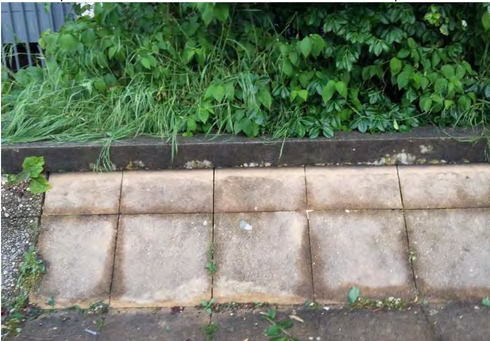
Constat du manque d'entretien des relevés ( la végétation pousse au travers)
