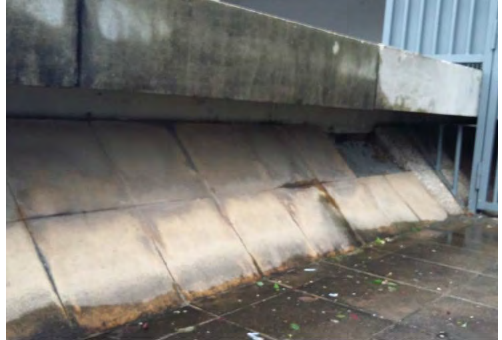
Constat du manque d'entretien des relevés
