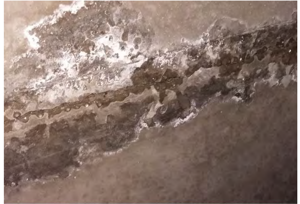
Constat de formation de calcite en plafond suite aux infiltrations d'eau
