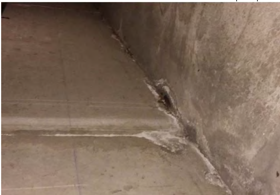
Constat de formation de calcite et traces visibles en mur des infiltrations d'eau par le plafond
